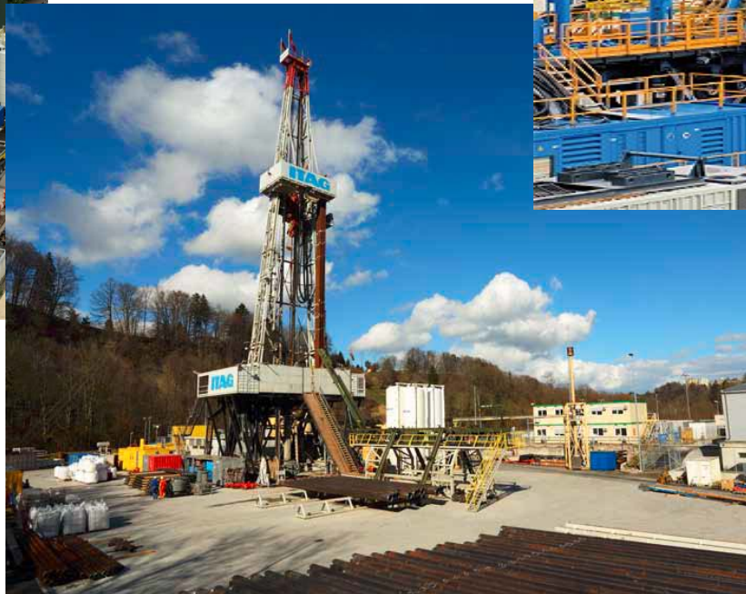
Geothermiebohrung St. Gallen
